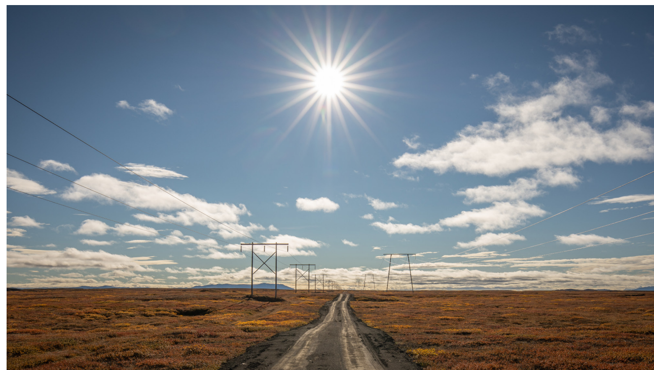
Dæmi 1. Nýleg línuslóð milli Kröflulínu 2 og 3
